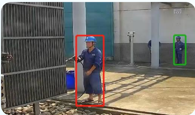
施工标准化检测
